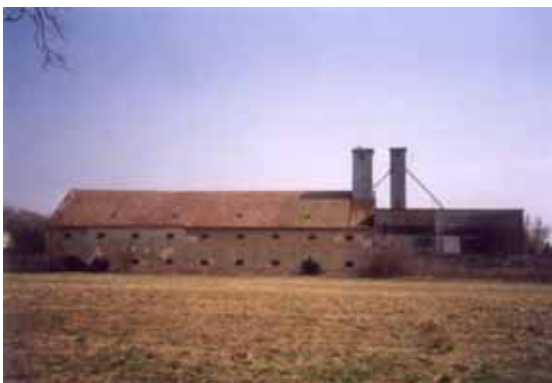
Die angebaute Trocknungsanlage stört die Ansicht des alten Getreidespeichers, der heute im Besitz der Erzdiözese Wien ist.
